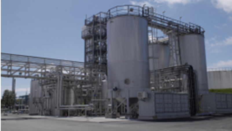
Den nya etanolanläggningen i
